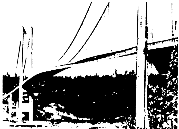
Рис. 14.14. Сильный порывистый ветер вызвал колебания Такоумского моста с большой амплитудой, что привело к его разрушению 7 ноября 1940 г. (Wide World Photo.)
